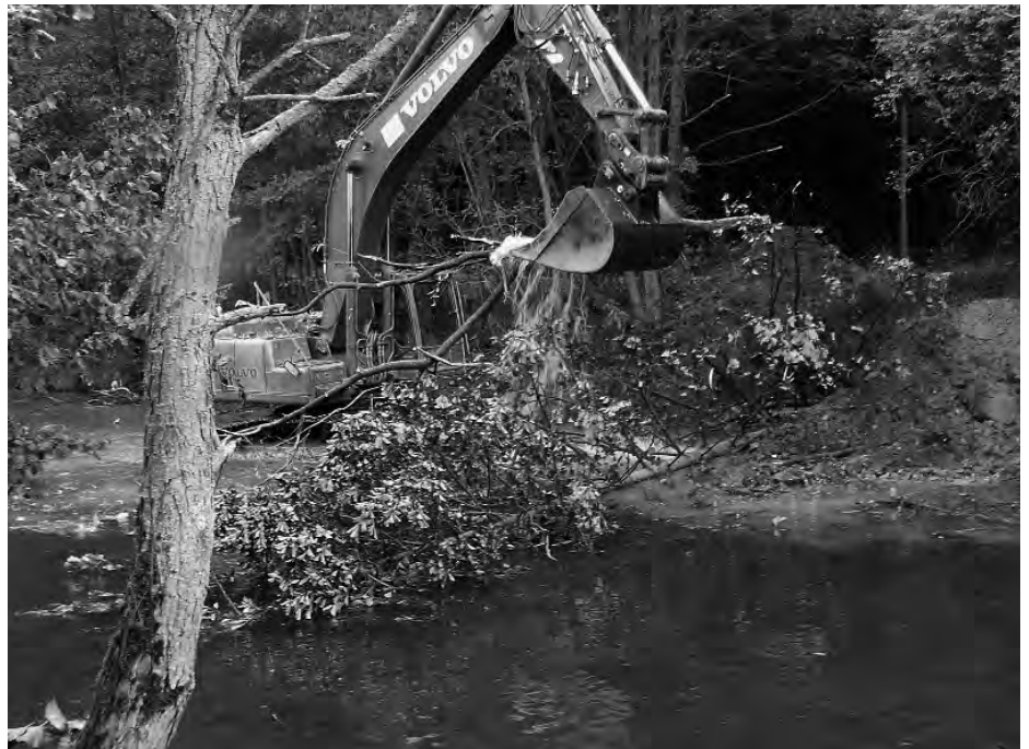
Abb. 6: Einbau von Totholz als kostengünstige Methode zur Revitalisierung an der thüringischen Ulster oberhalb Pferdsdorf. Foto: Matthias Metzger
