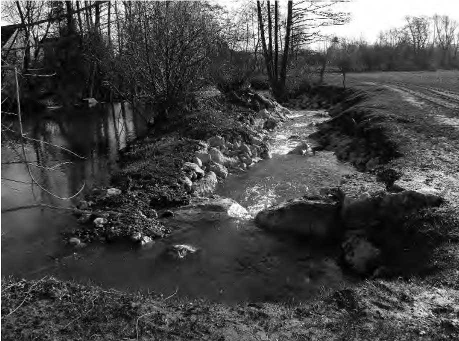
Abb. 5: Neu angelegtes Umgehungsgerinne (Ballingsmühle, Brend).
